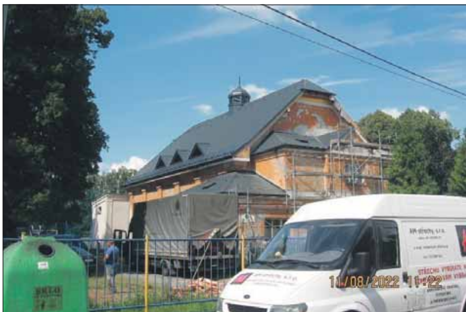
Pohled na objekt sokolovny s novou střešní konstrukcí z Tyršovy ulice.
