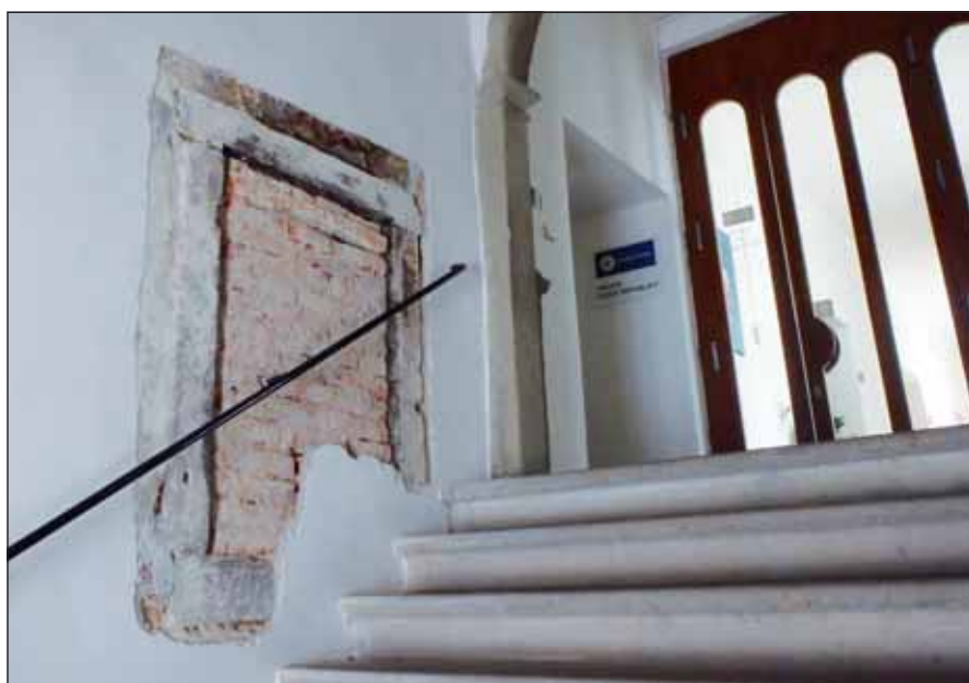
V zámku probíhá stavebně-historický průzkum pravděpodobně příkladacího portálu.
